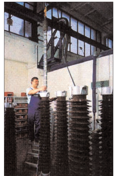
Montage der Hochspannungsableiterbausteine/ Assembly of arrester units
