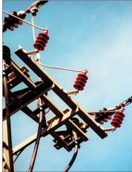
24 KV Ableiter mit Silikonisierung/ 24 KV arrester with silicon housing
