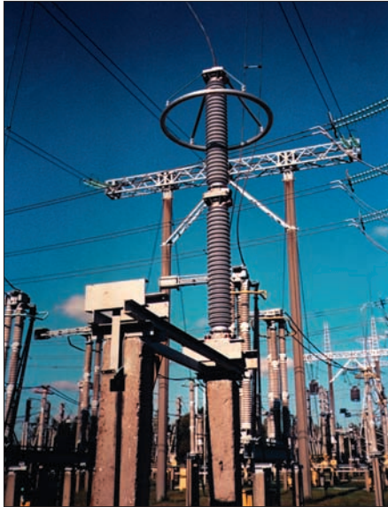
330 KV Ableiter mit Silikonisierung/ 330 KV arrester with silicon housing
